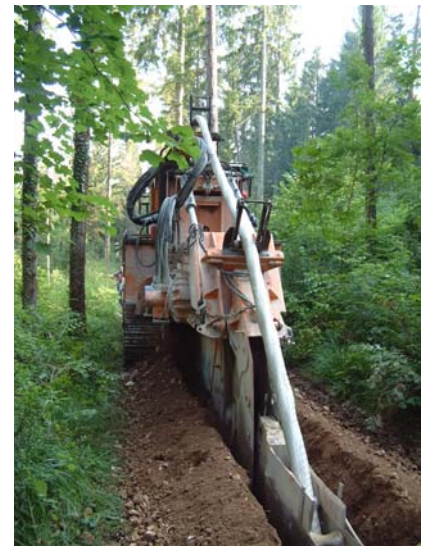
Trancheuse en pleine terre.
